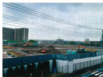
大型物流施設の建設予定地（5月15日撮影）
