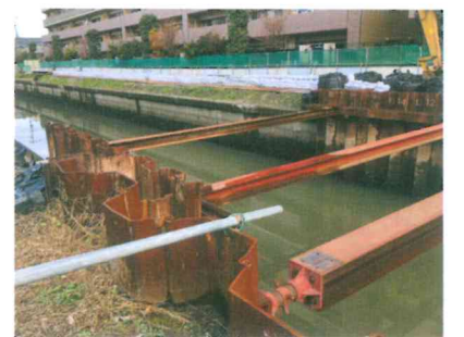
さくら川： 南根木の橋の周辺工事中の護岸
