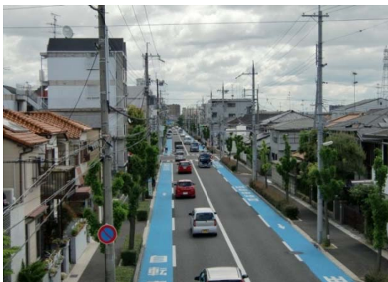
県道西宮豊中線自転車レーン (兵庫県尼崎市)
