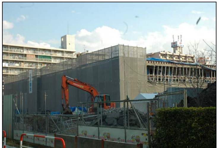
市内の建設現場の様子
