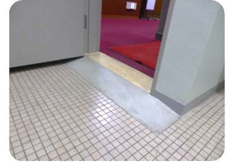
市役所庁舎のトイレ。段差が解消されている。
