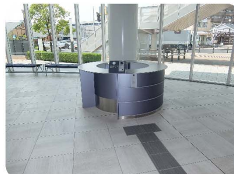
視覚障害者誘導用ブロックの事例。左は、刈谷市総合文化センター・アイリス。右は、新潟県長岡市のアオーレ長岡。どちらも、一般的に使用される黄色のブロックではないが、輝度比を確保することで、弱視の人が識別しやすいように配慮している。アオーレ長岡では、視覚障害者の意見を聴きながら整備を進めた。
