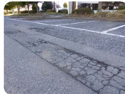
劣化が激しい駐車場。つまづきやすく、危険な状況であり、補修が必要。
