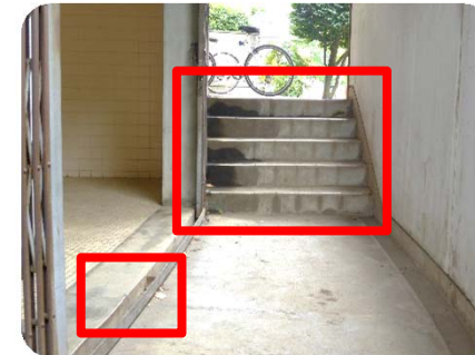
福祉施設のトイレ。施設内の段差は完全には解消されていない。
