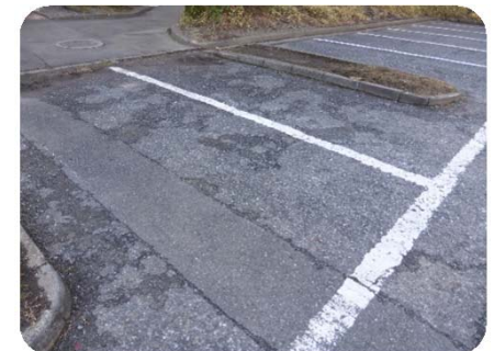
劣化が激しい駐車場。つまづきやすく、危険な状況であり、補修が必要。
