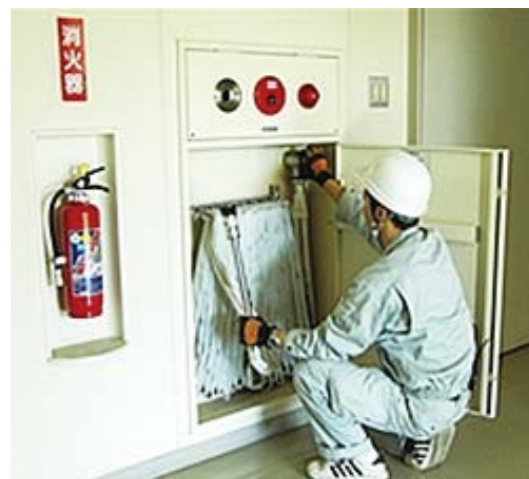
消防用設備点検(株式会社堀内防災ホームページより)
