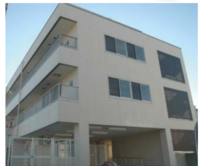
▲新曾北小学校南側に建設中の学童保育室
