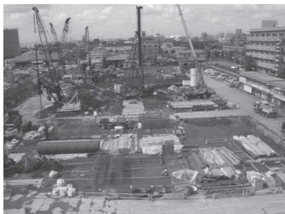
▲ 15階建てのマンション建設が進む事業所跡地
