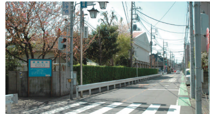
▲ゾーン30対策工事で整備されます（喜沢小西側）
