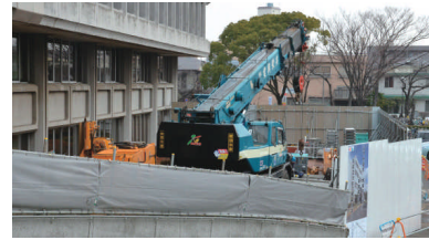
▲耐震等改修工事中の公共施設（市役所本庁舎）
