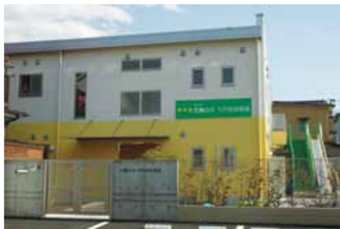
▲平成24年4月に開園した「太陽の子」下戸田保育園
