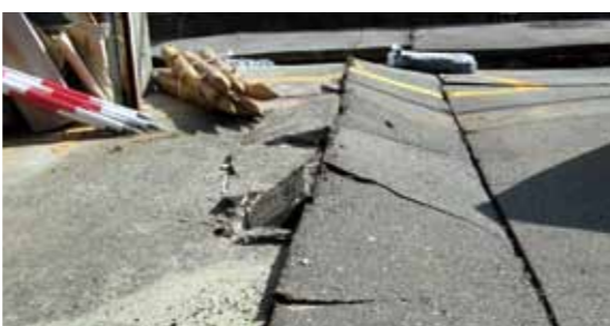
▲液状化の跡 能登半島地震・輪島市 (提供: 財団法人消防科学総合センター)
