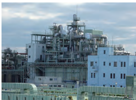
▲荒川水循環センターの焼却炉
