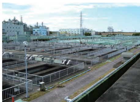
▲未整備の第1～第4系列(荒川水循環センター)
