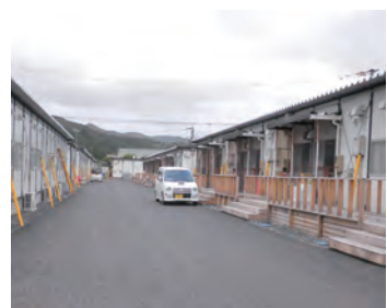
▲女川町総合運動場の仮設住宅
