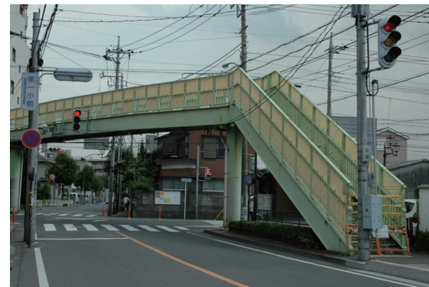
▲震災で被災し、撤去される上戸田第1歩道橋
