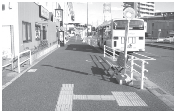
▲駅から途切れた点字ブロック
