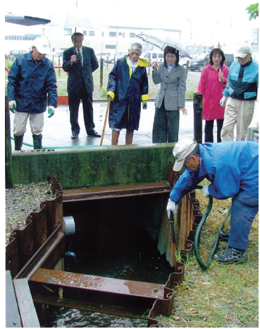
▲ EM液によるユスリカ対策の現場
