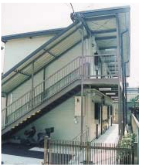
▲新設された自立支援ホーム
