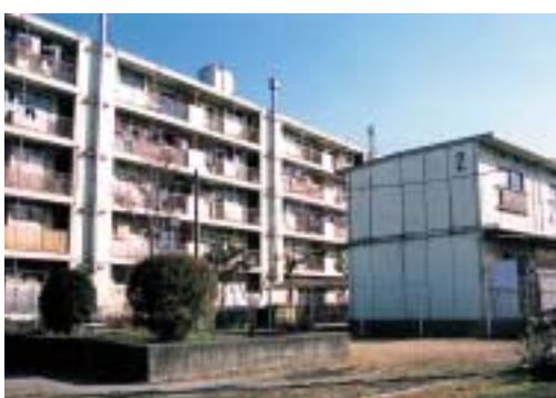
▲建て替えが急がれる下笹目住宅
