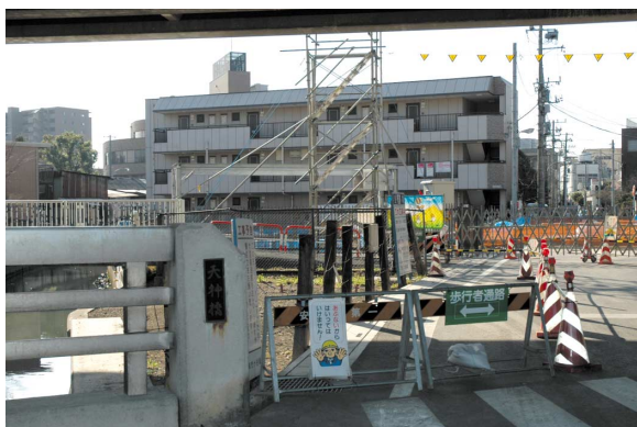
▲上戸田川に浄化施設を建設中（天神橋付近）
