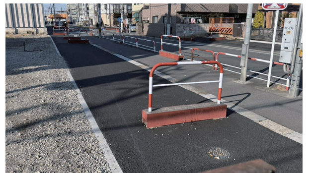
拡幅及び電線共同溝整備の工事が着々と進んでいます
