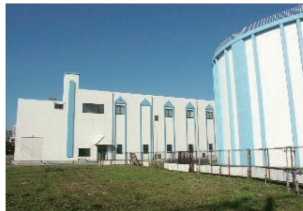
更新を迎える浄水場の整備にも多額の財源が必要です（写真：東部浄水場）
