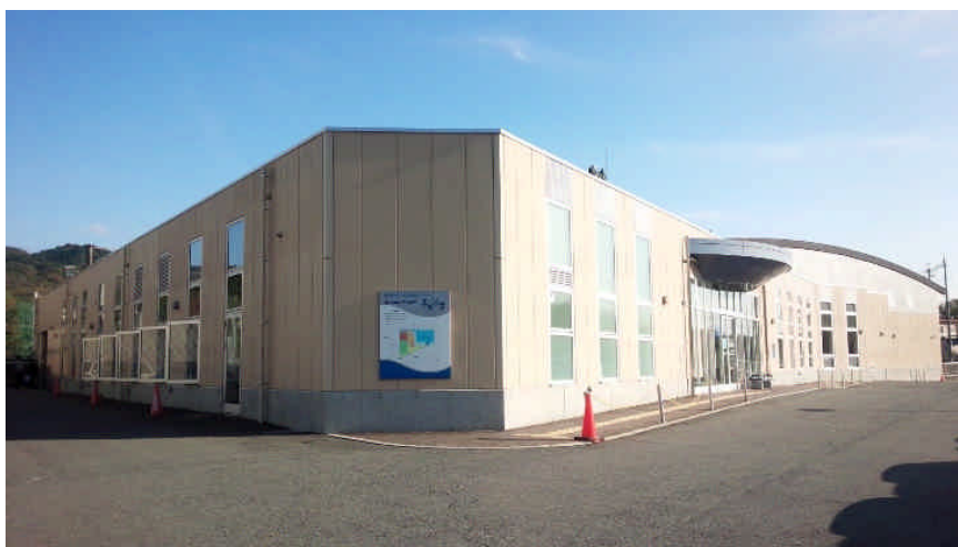
▲井手山屋内温水プールの外観
