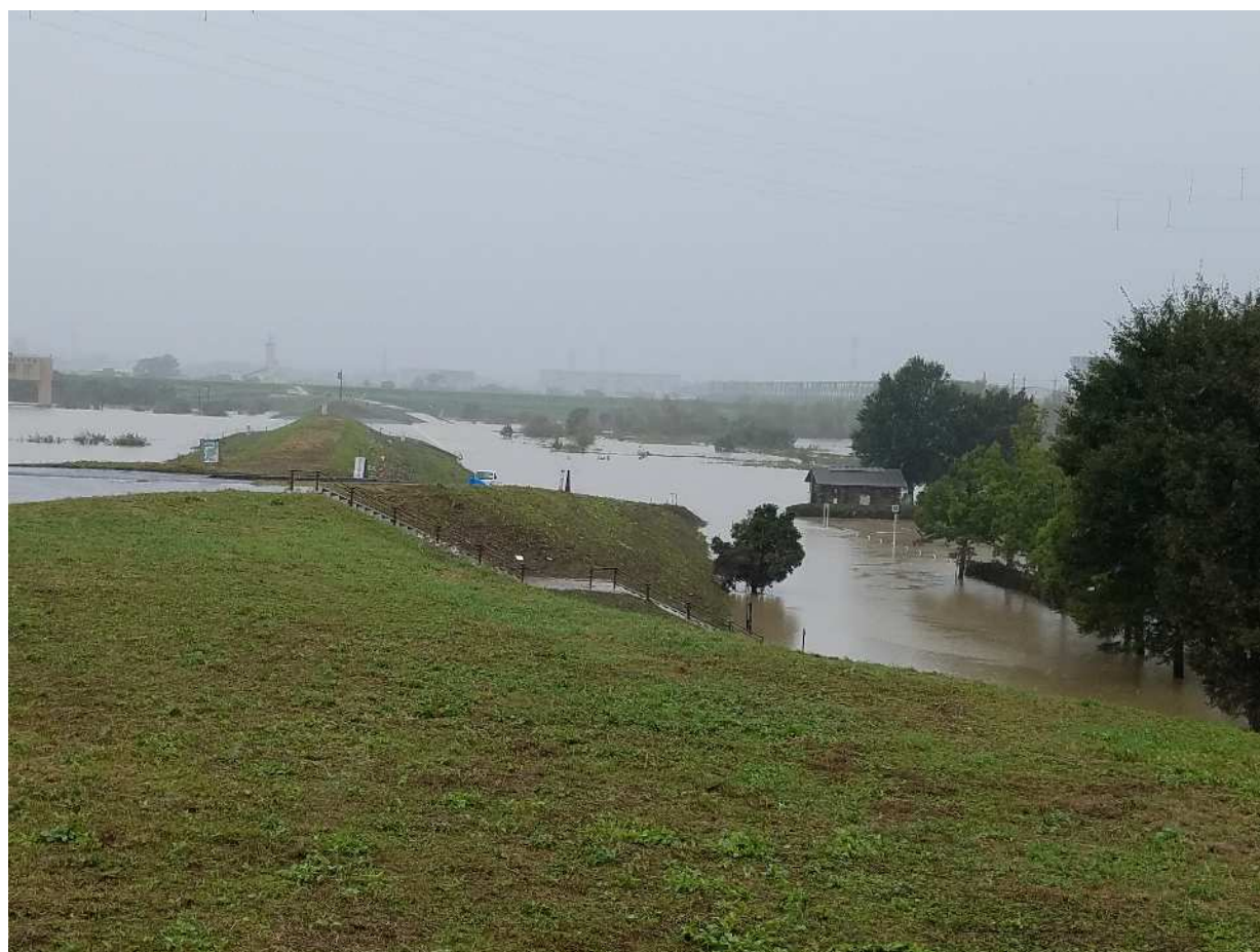
令和元年台風第19号により冠水した彩湖・道満グリーンパーク
