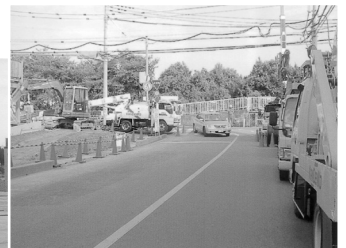
▲新設される川金橋付近
