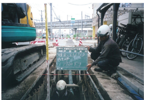
50ヶ先の新曽福祉センター西交差点までの区間に本管と汚水ますを整備す
