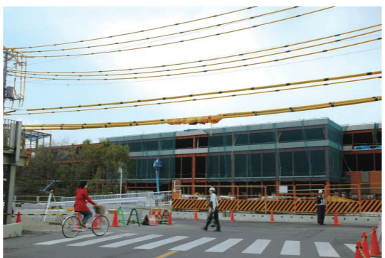
▲建設が進む(仮称)ララガーデン
