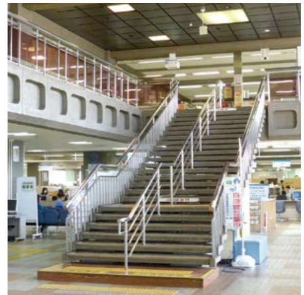
▲撤去が予定されている市民課前の階段
