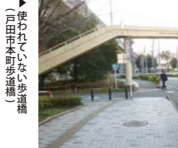
使われていない歩道橋（戸田市本町歩道橋）
