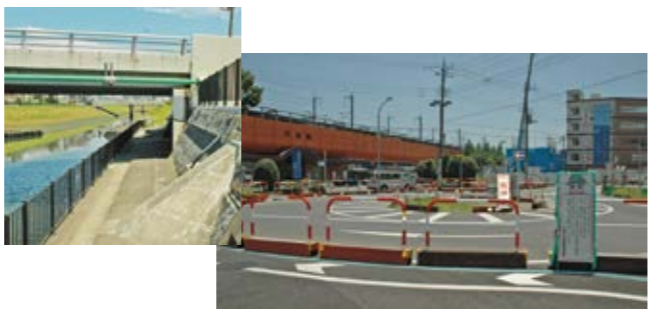
▲山宮橋の下通路・戸田駅前の環状交差点
