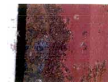
耐震補強用の鉄骨に、さびや腐食が確認されるため、腐食した鉄骨表面の研磨及び塗装が必要
