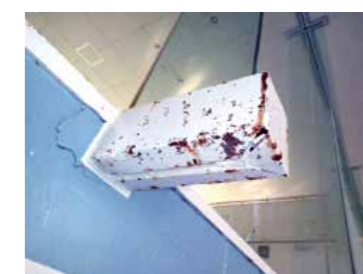
観覧席のガラスを支える鋼製部材の腐食による落下の恐れがあるため、鋼製部材の撤去・新設（補強含む）
