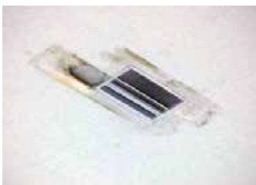
湿気を含んで重くなった天井部材の一部が落下したため、国の新たな基準に沿った天井へ改修
