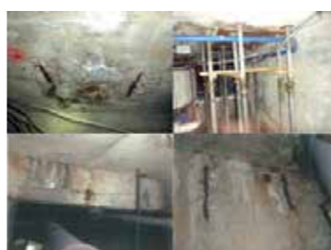
床部材全般にわたり、ひび割れや鉄筋の腐食が見られるため、鉄筋コンクリートを解体・新設する
