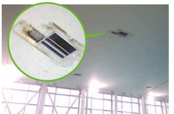
戸田市スポーツセンターの天井落下部分
