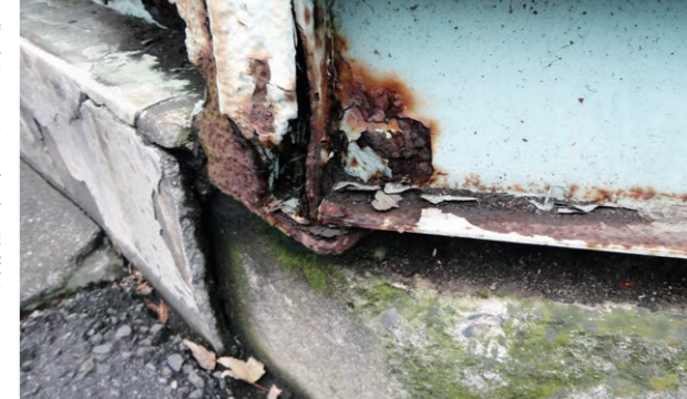
腐食している喜沢中学校の防音壁土台部分
