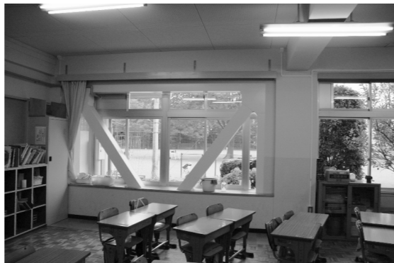
▲計画的に進む学校の耐震化工事（美谷本小学校）
