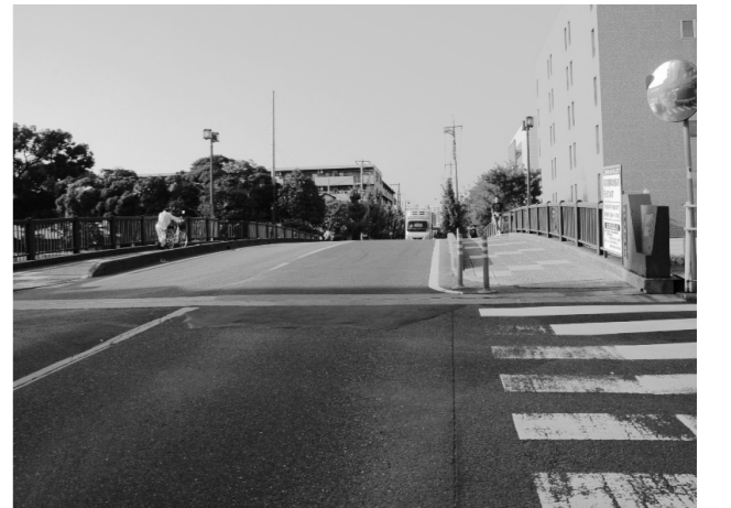
▲見通しが悪く、安全対策を求められる川岸橋
