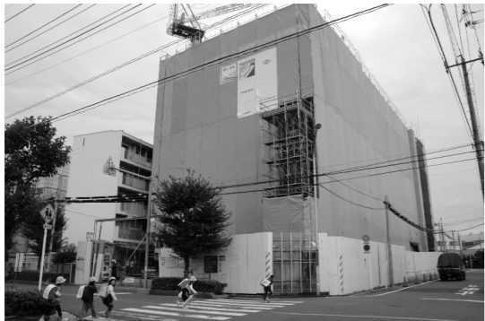
▲平成21年10月の完成に向けて工事が進む下笹目住宅
