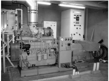
▲これで電灯がつけば…庁舎地下の自家発電設備
