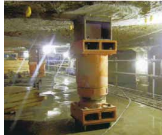
▲品川区総合庁舎免震工事現場
