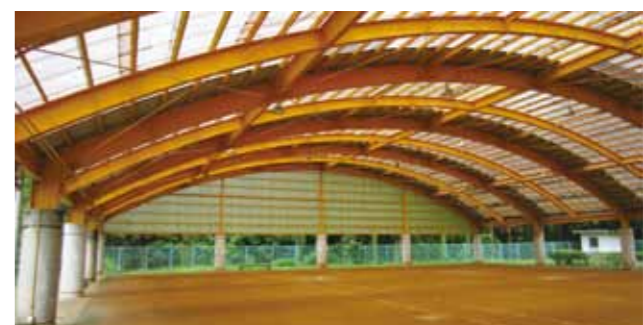
▲天瀬屋根付き運動広場（大分県日田市）
