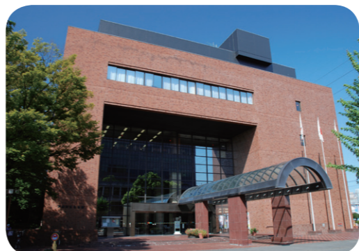
▲公共施設マネジメント白書の対象となる市の施設（戸田市文化会館）
