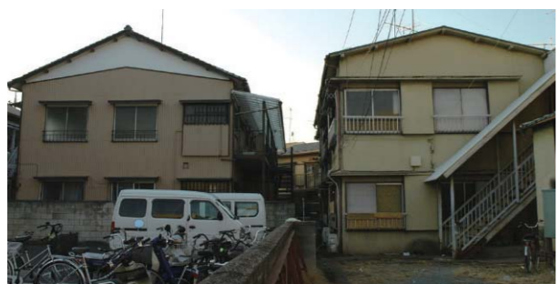
▲市内にまだ多く残る賃貸住宅
