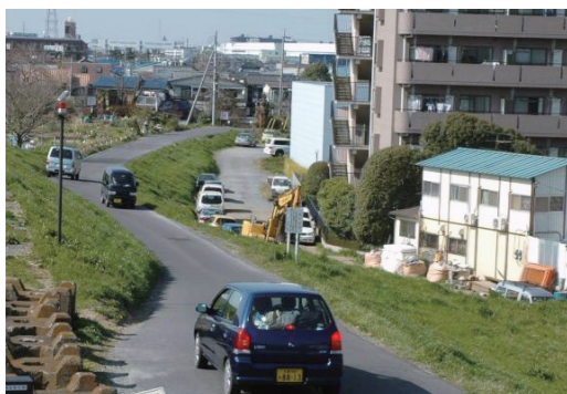
▲存廃の岐路にある荒川河川管理用道路
