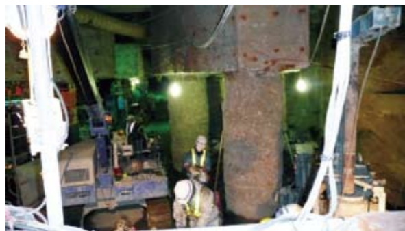
▲免震レトロフィットによる品川区総合庁舎の工事を視察
