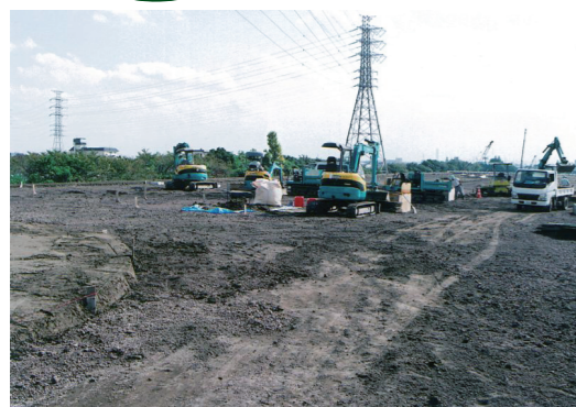
▲ 着々と進む荒川水循環センター上部工事
