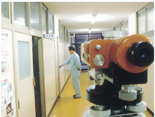
▲16年度に実施した学校の耐震診断
