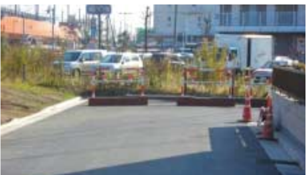
▲工事は暫時停止。この先に戸田駅が見える
