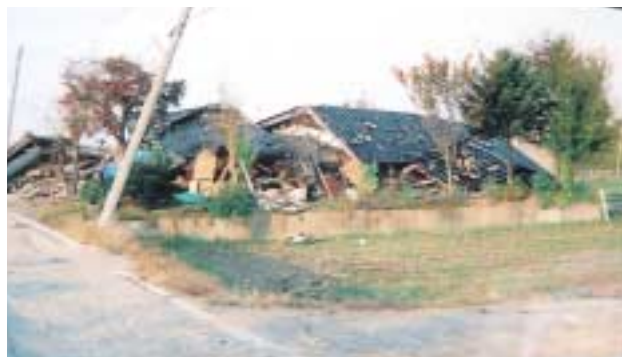
▲耐震化の重要性を教訓した一昨年の新潟県中越地震
