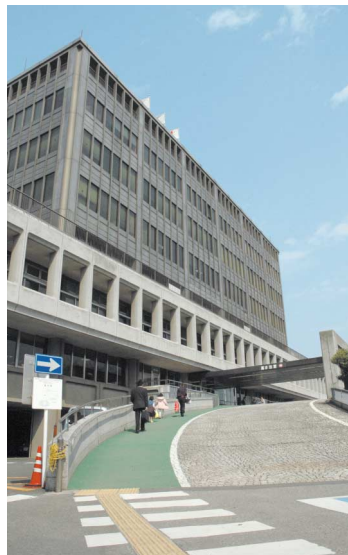
▲2階正面玄関にエスカレーターを
