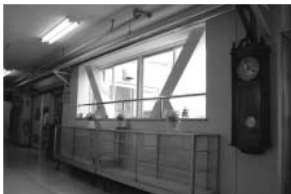
▲ 窓枠に「プレス」をつけて耐震補強しています
