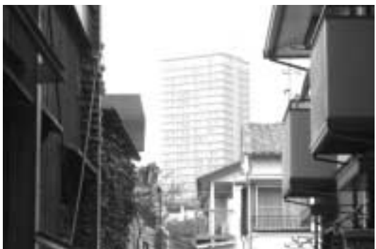
▲ 閑静な住宅街に、突然高層建築物ができたとしたら…
