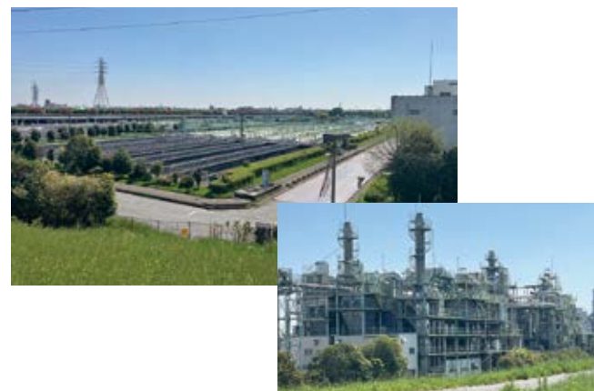
下水処理が行われている荒川水循環センター
