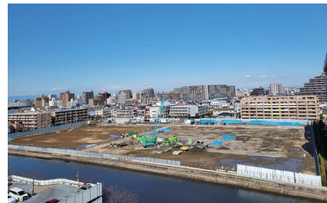
物流施設の建設が進む川岸地区
