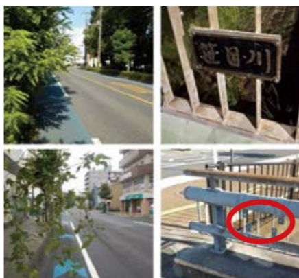
橋名板の盗難現場(右)と、自転車通行空間に枝が伸びている現場(左)の様子
