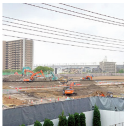
▲大型物流施設建設予定地(5月13日撮影)
